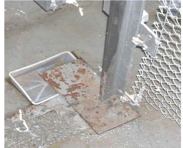
Şekil 3.2: Rayın konsola bağlantısı
