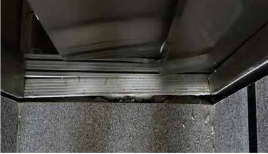
Şekil 4. Birinci kaza Makine dairesiz asansör kat kapısı durumu
