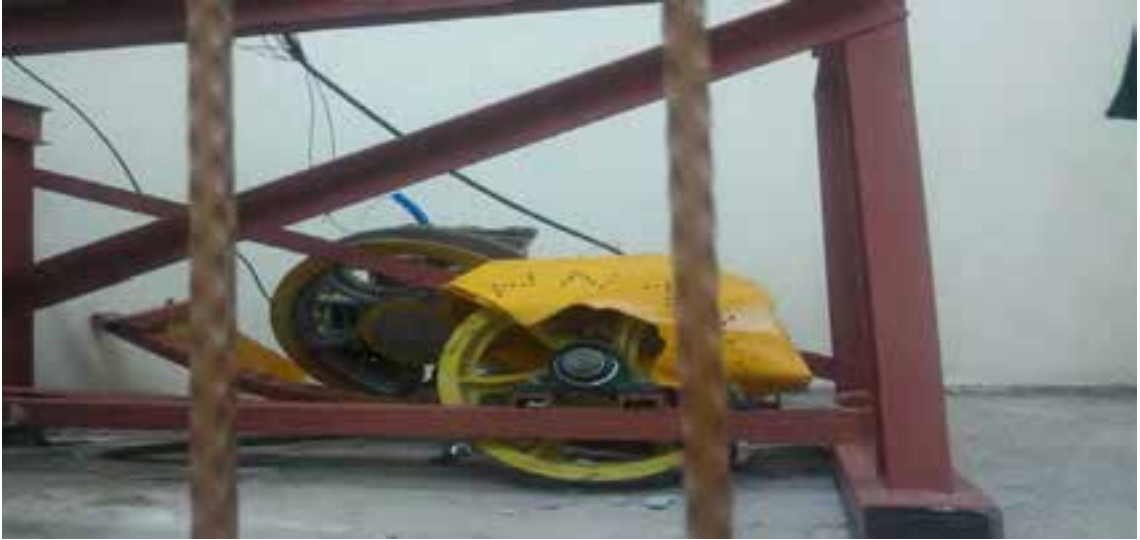
Şekil 5. İkinci kaza makine dairesiz asansör makine motor görünümü
