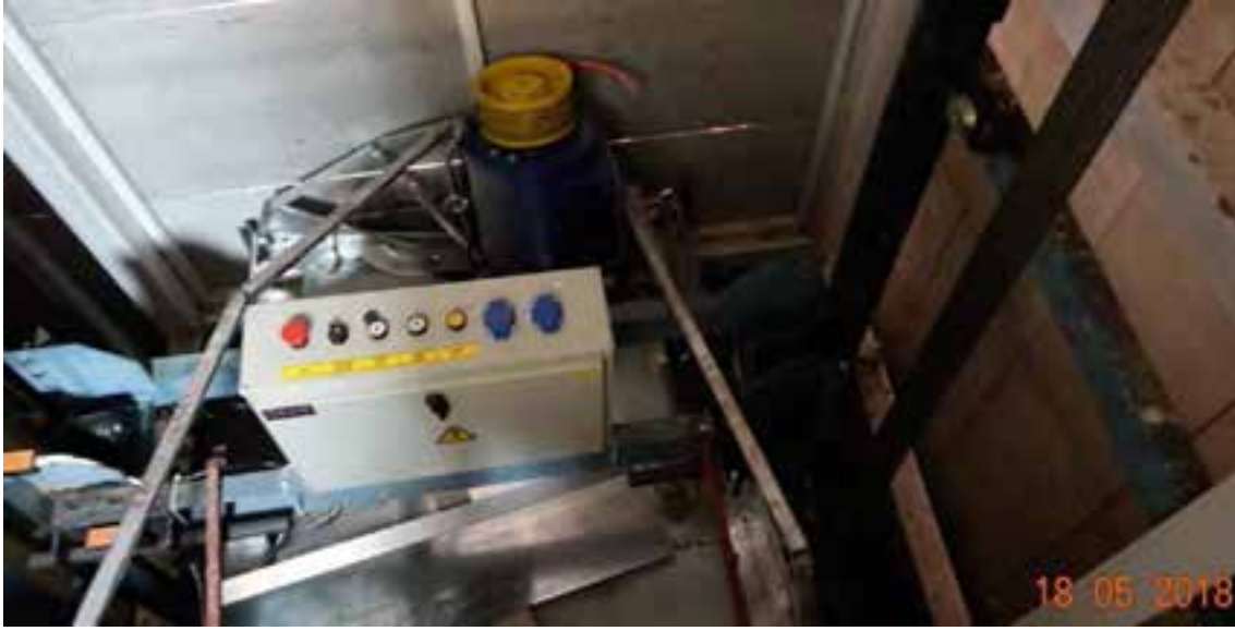
Şekil 2. Kaza 1 makine dairesiz asansör kabin üstü
