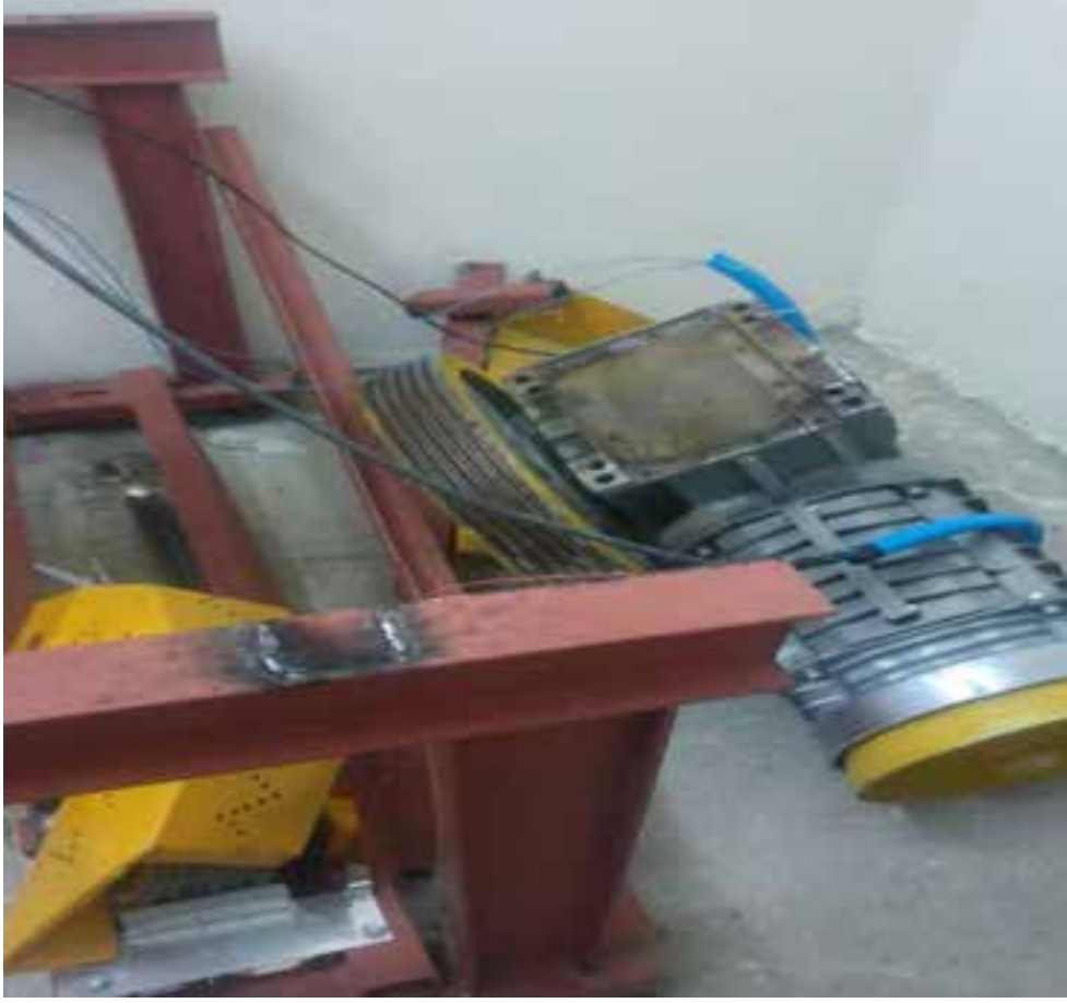
Şekil 6. İkinci kaza makine dairesi asansör, makine motor sehpa görünümü
