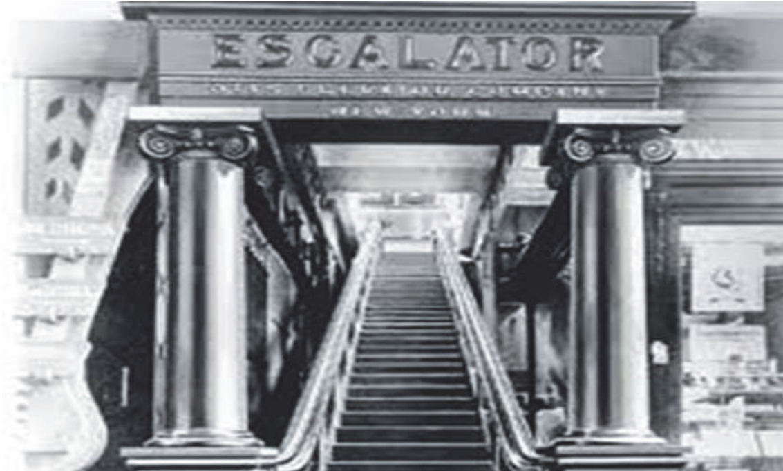
Şekil 1. Patentinden 3 yıl sonra New Yorkta eğlence merkezinde 25 ° lik açılış eğimle kurulmuştur.
