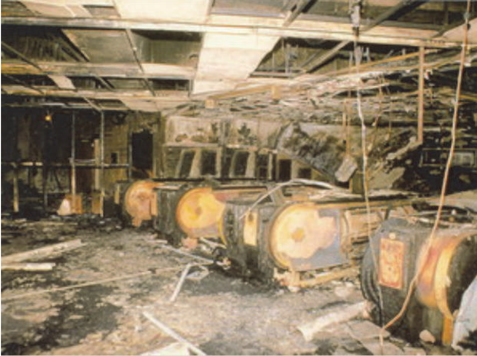
Şekil 8. Zincirlerin yağlanması için kullanılan kimyasallar yangın tehlikesi içerir
